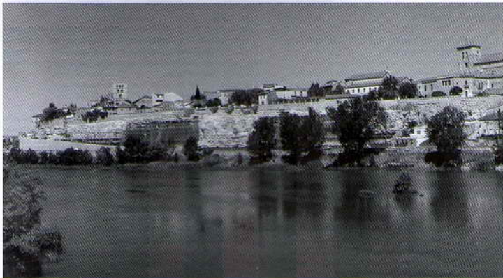
Peñas de Santa Marta (Zamora). Vista general de las obras.
