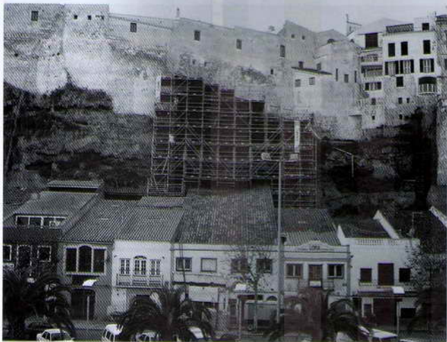
Vista general del acantilado del Puerto de Mahón. Andén de Poniente.
