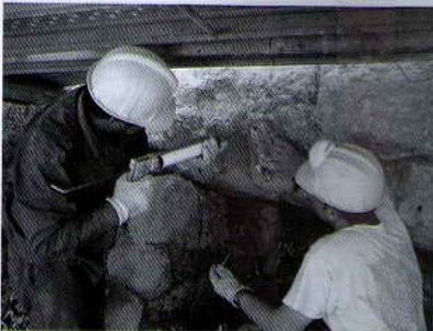
Microanclajes e inyección de resina.
