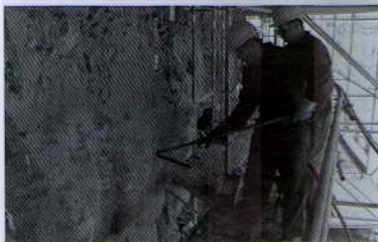
Colocación de buzones en fibra de vidrio.
