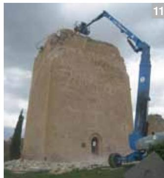
**Lámina 11.** Con una grúa móvil se empezó a eliminar el material suelto de toda la cubierta, mientras se acopiaban los sillares de piedra.
