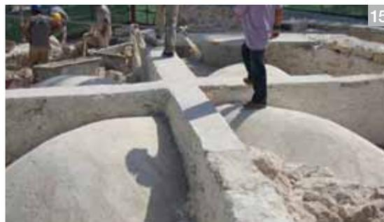
**Lámina 15.** Las bóvedas se refuerzan en su trasdós con un mortero de cal en el que se mezcla fibra de polipropileno.
