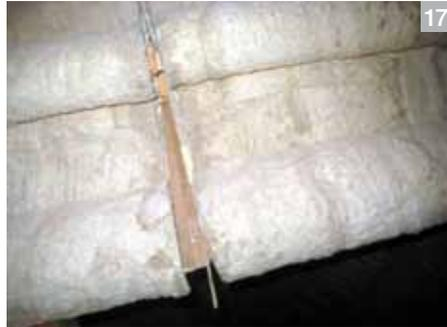
**Lámina 18.** Tras el acuñaamiento la junta se cierra con mortero de cal.
