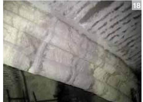
**Lámina 19.** Macizado superior del supradós de las bóvedas con zahorra y cal mezclada en seco. Un geotextil diferencia la capa de material que hemos añadido en nuestra restauración.
